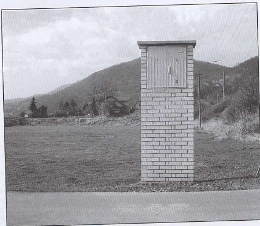
Probíhá úprava elektrických domečků.
